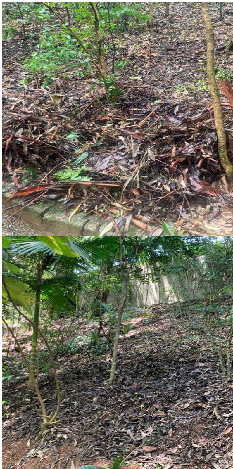
Figura 25 – Manutenção de taludes
