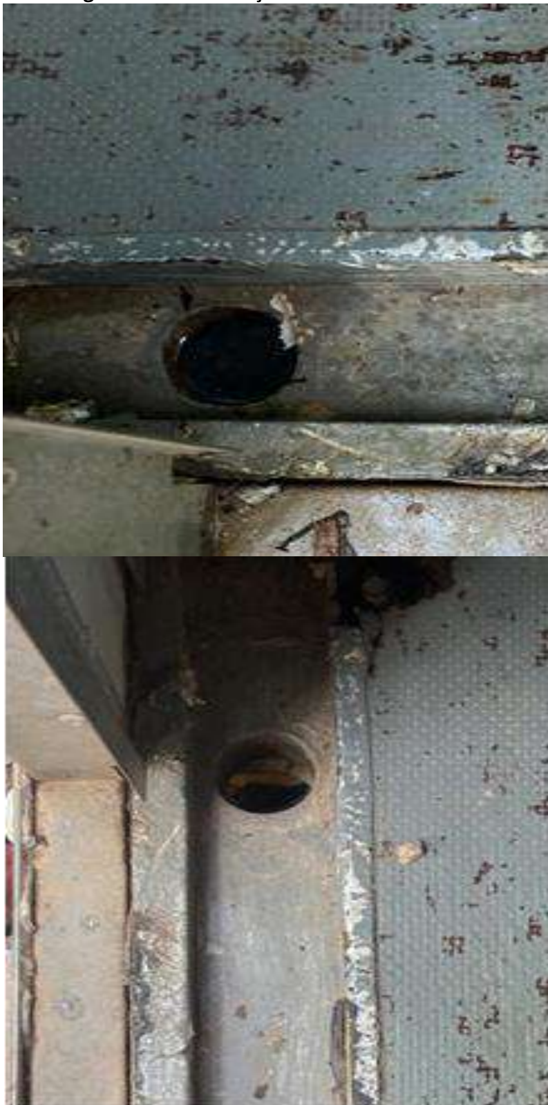
Figura 43 - Manutenção Hidráulica Containers
