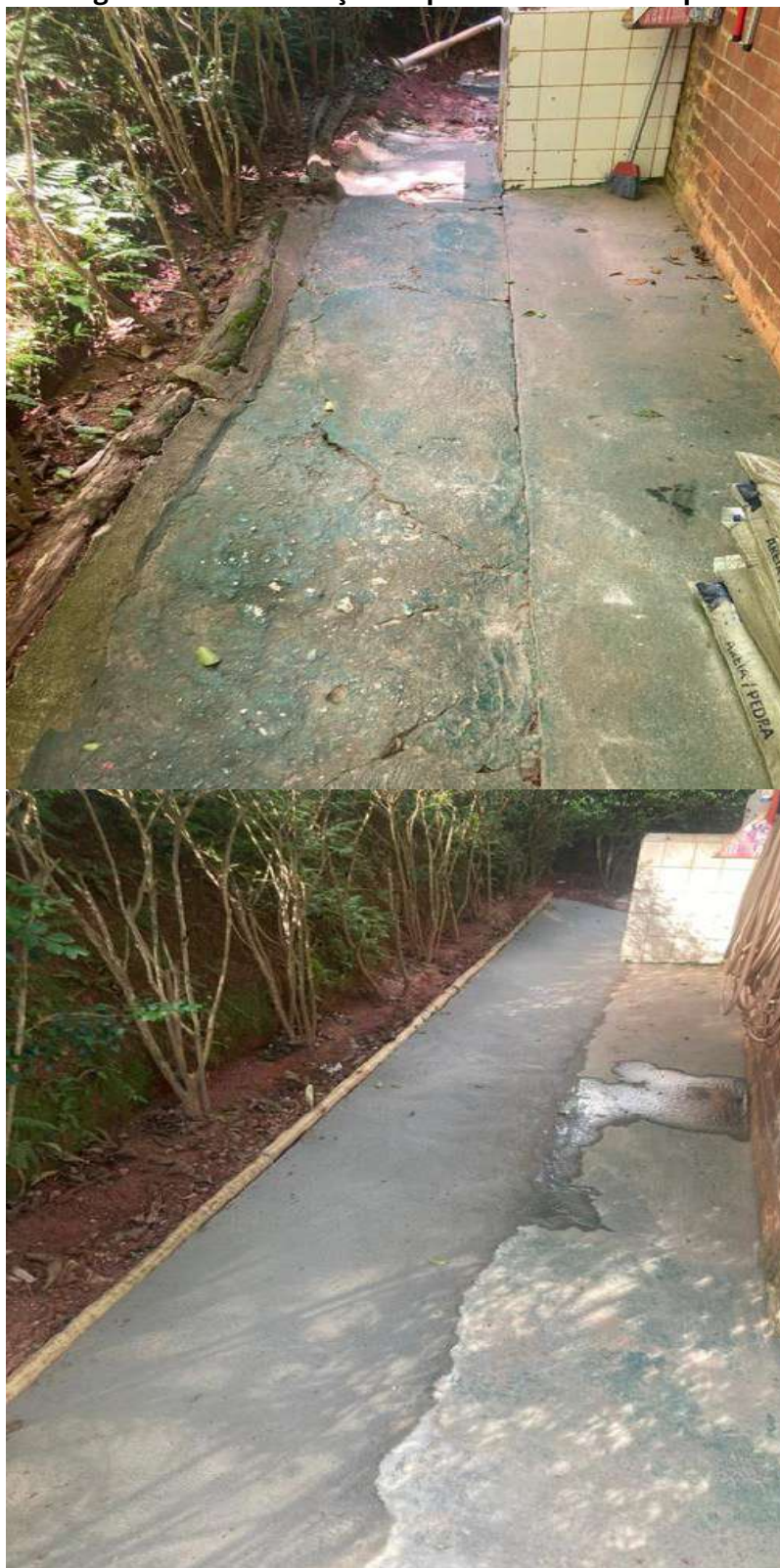
Figura 45 - Manutenção de piso da área do tanque
