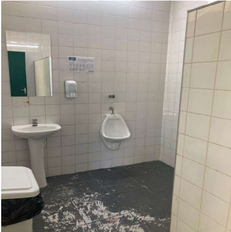
Figura 46 - Instalação de biombo para banheiro masculino
