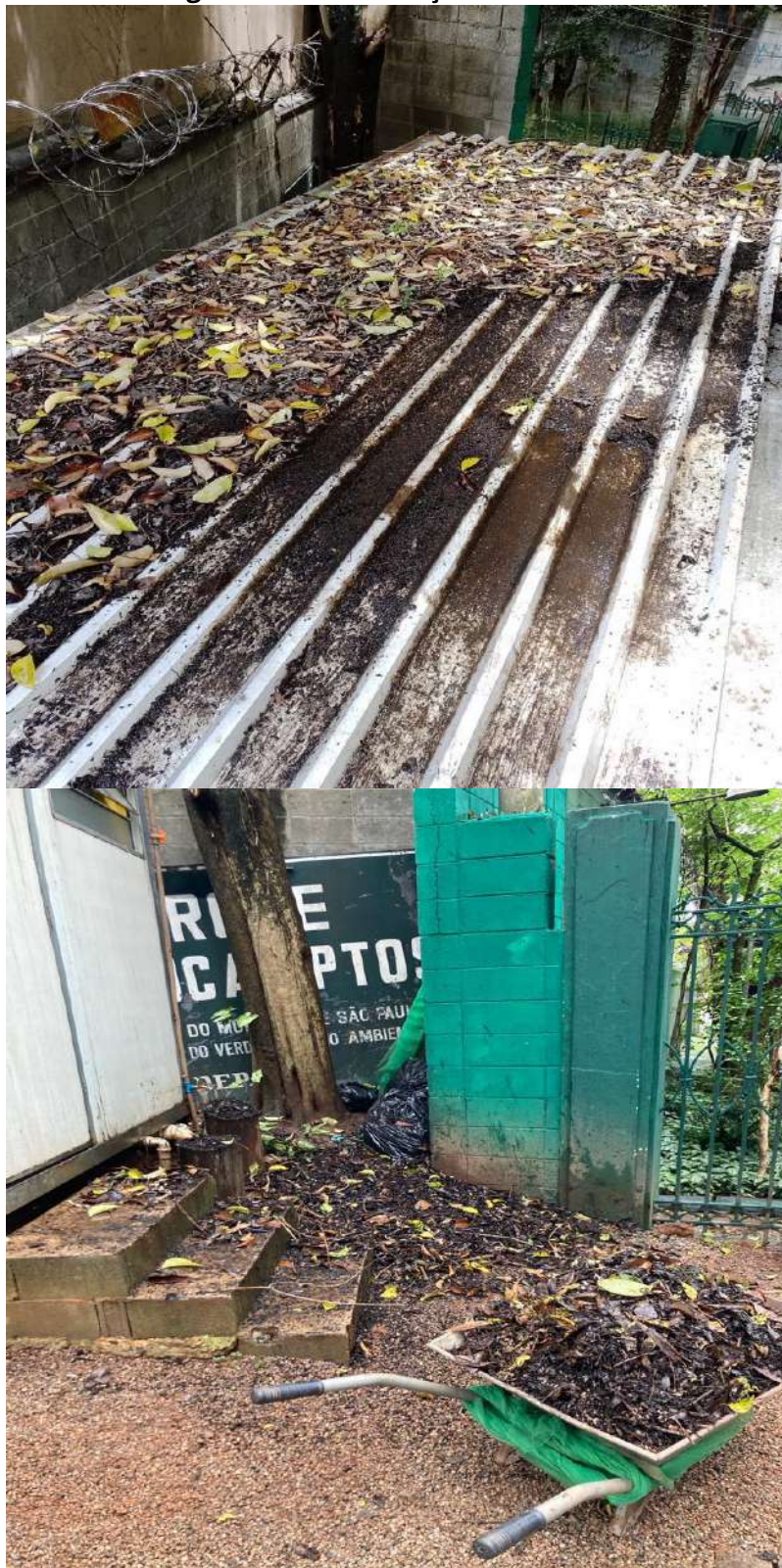
Figura 41 - Manutenção de telhados
