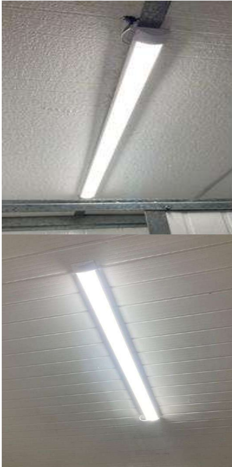
Figura 47 - Manutenção de luminárias containers e administração
