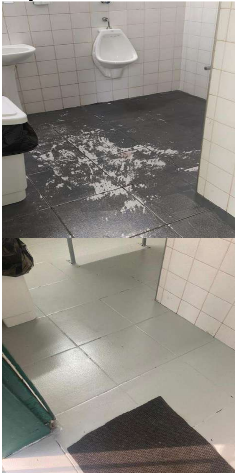
Figura 44 - Pintura do Piso do Banheiro Masculino
