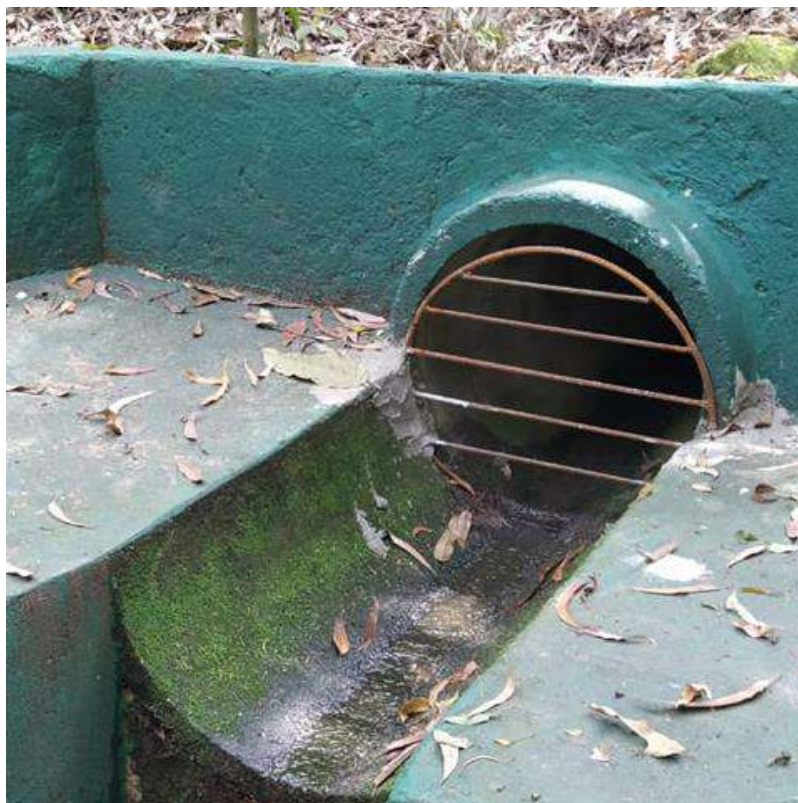
Figura 49 – Manutenção e instalação de grades protetoras
