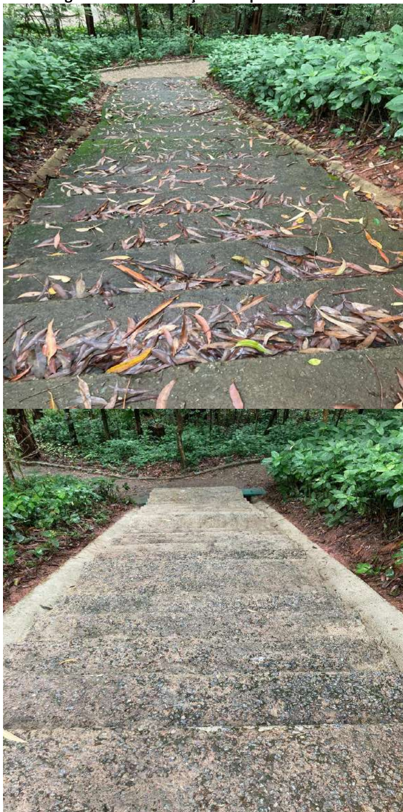
Figura 36 - Manutenção e limpeza de escadas
