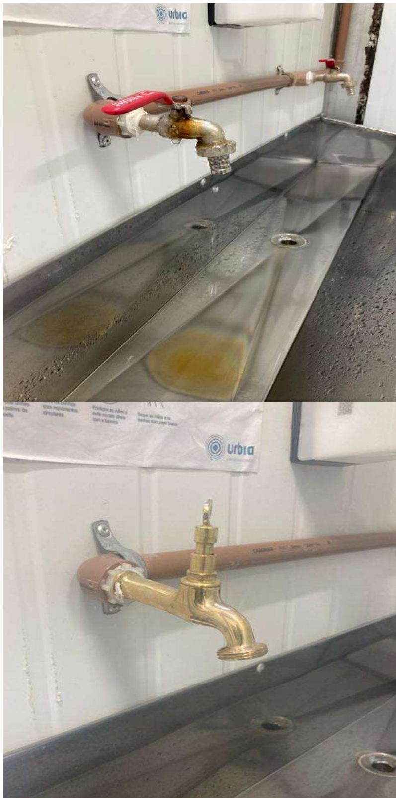
Figura 50 - Manutenção Hidráulica - trocas de torneiras
