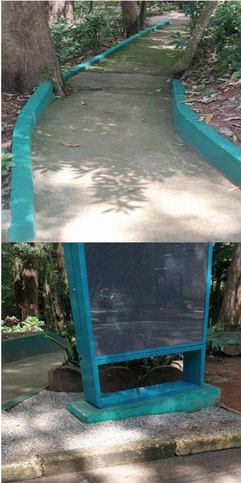
Figura 48 - Manutenção de muretas e bases para totens multimídias
